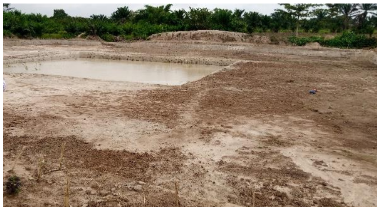
Réalisation de surcreusement dans la commune de Bohicon pour la rétention des eaux de ruissellement
