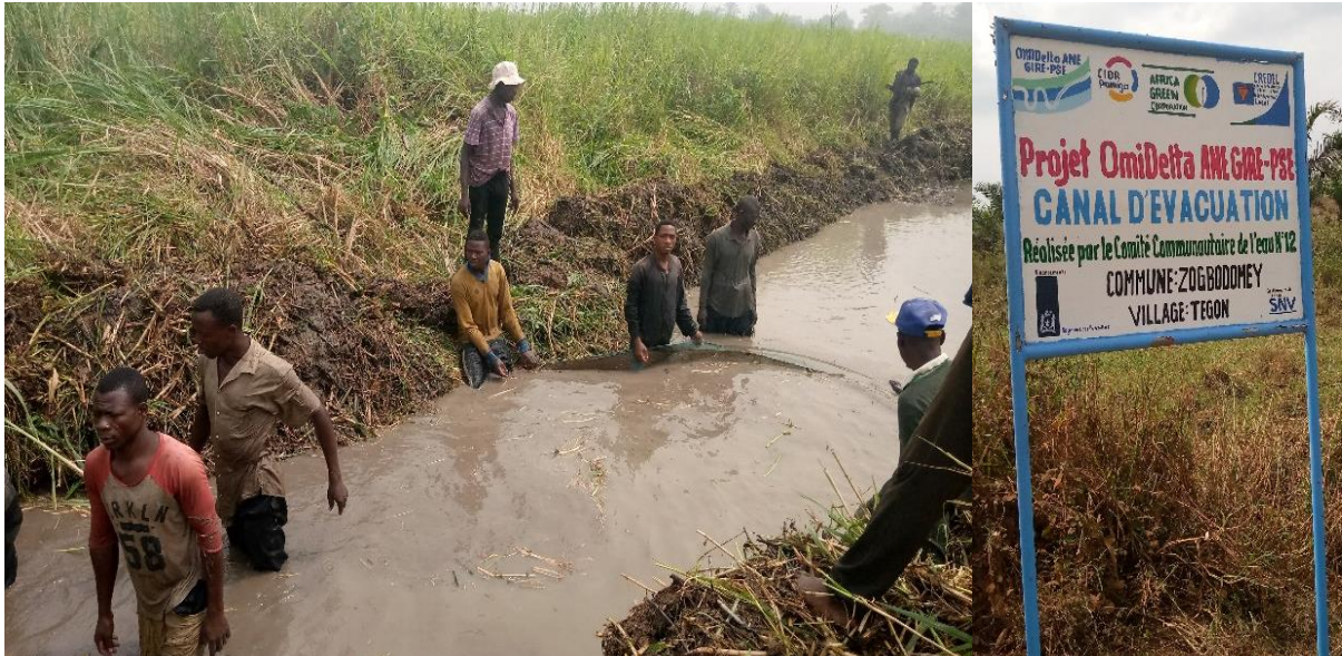
Curage de canal d'évacuation d'eau par le CCE 12 à Zogbodomey
