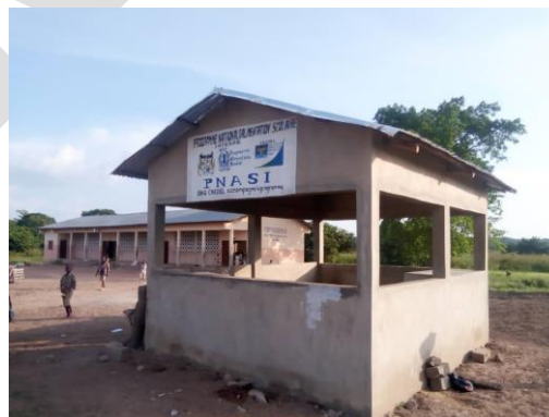
Photo 4 : Construction d'une cuisine à EPP/Thio
