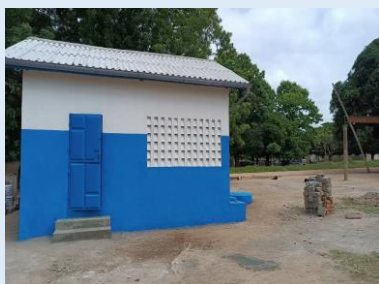
Photo 10 : Modèle de cuisine construite dans les EPP Agboro-Kombon et Ikémon par Plan International Bénin à Ouessè (PNASI)
