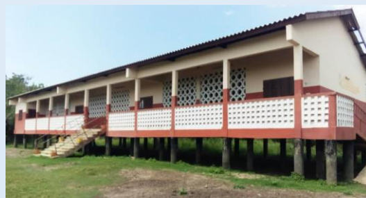
Photo 19 : construction d'une école en hauteur à Monoto (SAPC-Mono)
