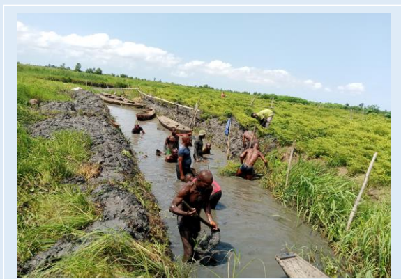
Photo 24 : Travaux de curage de drains à Dangbo
